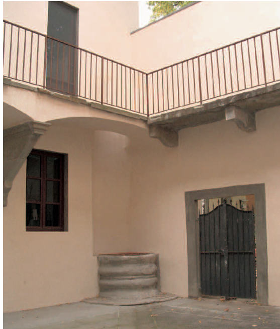
Corte interna, con pozzetto, di Casa Lapi
