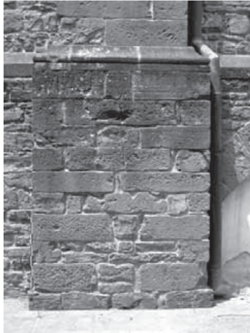
Figura 96 – Chiesa di Santa Croce, Firenze, particolare del paramento esterno del transetto.
