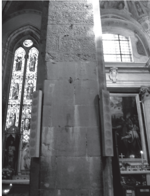
Figura 97 – Chiesa di Santa Croce, Firenze, particolare del paramento di una lesena fra la seconda e la terza cappella del transetto destro.
