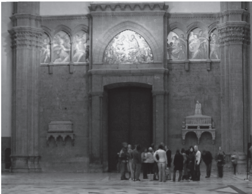
Figura 87 – Cattedrale di Santa Maria del Fiore, Firenze, vista della controfacciata.
