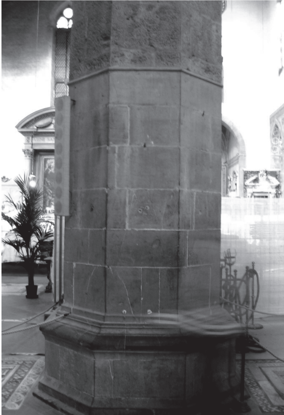
Figura 104 – Chiesa di Santa Croce, Firenze, vista del pilastro fra le navate centrale e laterale destra.
