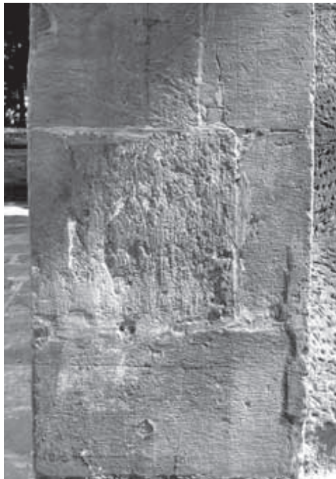
Figura 99 – Porta a San Gallo, Firenze, particolare del paramento interno dell'apertura.
