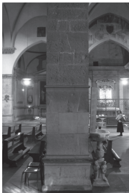
Figura 103 – Chiesa di Santa Trinita, Firenze, particolare del pilastro fra le navate centrale e laterale sinistra.
