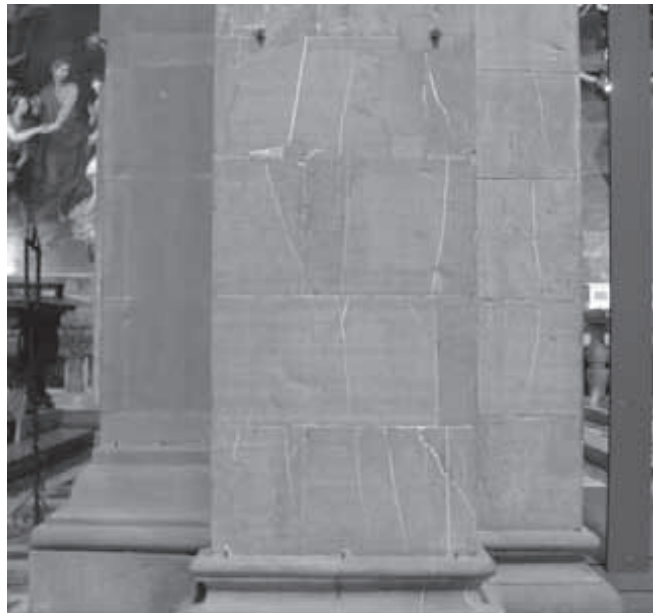
Figura 91 – Chiesa di Santa Maria Novella, Firenze, particolare della lesena fra le cappelle del braccio sinistro del transetto.
